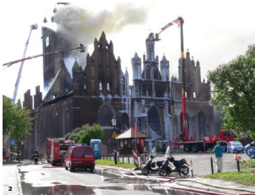
2 | 3 | Kościół św. Katarzyny w Gdańsku w czasie pożaru (2) i po remoncie (3)
